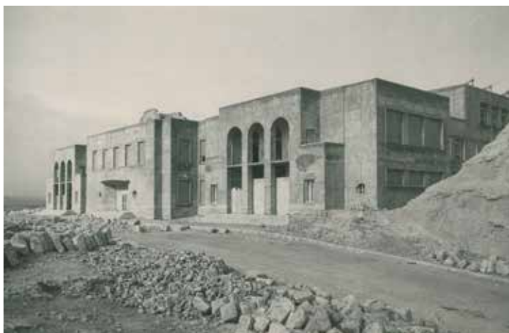
Construcció al Tossal de la seu de l'Institut Nacional de Segona Ensenyança d'Alacant, [1940s]. Cedida per l'IES Jorge Juan.
