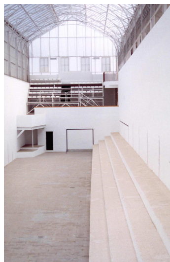
Rehabilitació Trinquet de Manises
